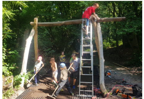
Unsere fleißigen Helfer in den Sommerferien beim schweißtreibenden Bau der neuen, barrierefreien Vogelnechtschaukel.
